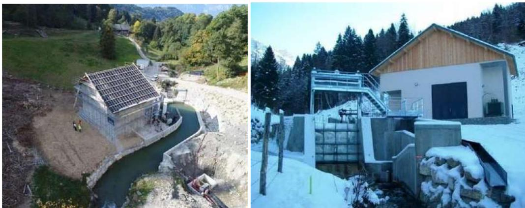
*Charpente, toiture, bardage et traitement des façades extérieures*
