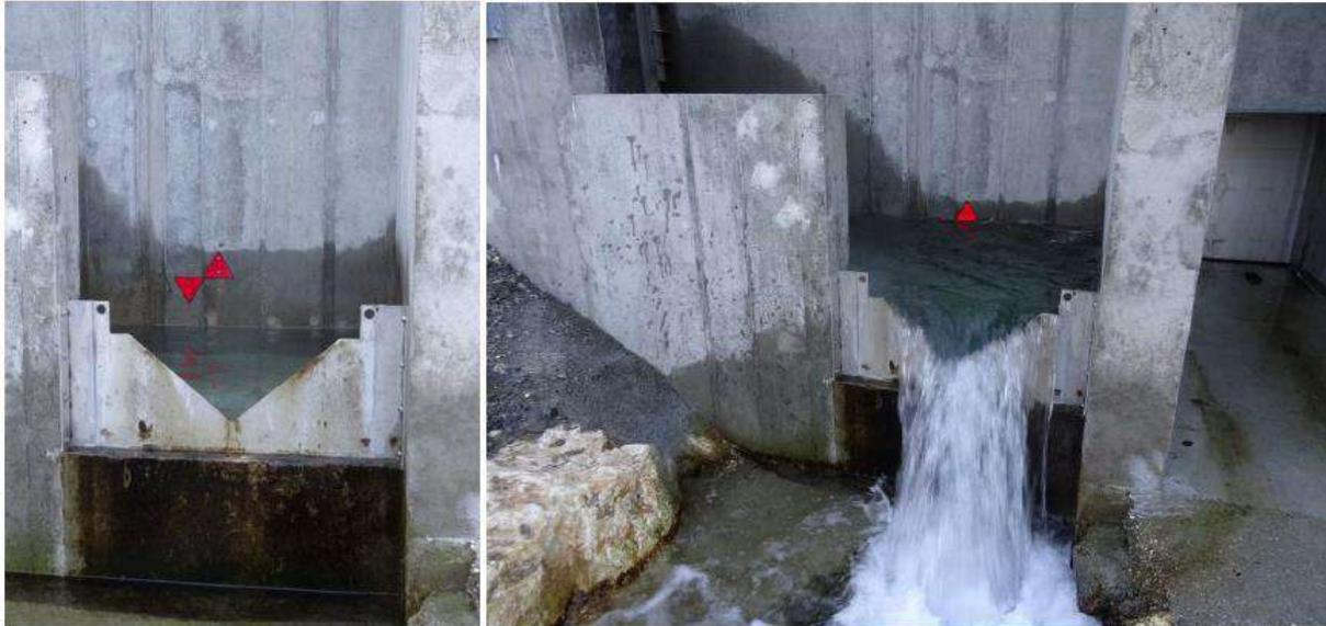
**Figure 26 : Exemple de contrôle de la délivrance du Qr par catadioptres**
