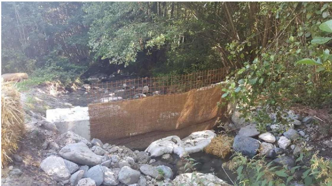
**Figure 67 : Exemple de dispositif de filtration des MES en lit mineur (ici sur le torrent du Vorz en Isère lors des travaux de rénovation de la prise d'eau)**
