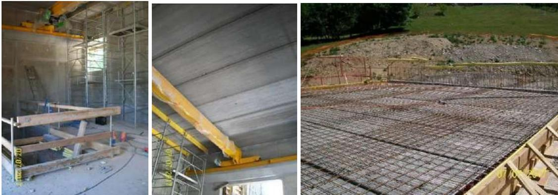
*Réalisation de la dalle de fermeture de l'usine avec pré-dalles alvéolaires et dalle de compression*
