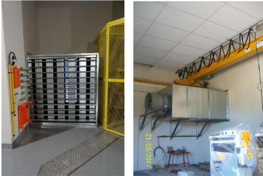
**Figure 37: Exemple d'entrée d'air et extraction d'air avec pièges à sons**
