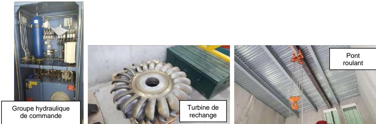
**Figure 40 : Equipements intérieurs de la centrale (ex de Glaize)**
