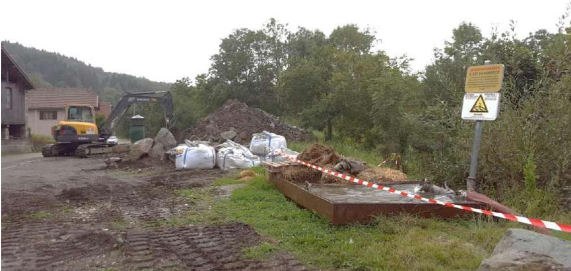
**Figure 66 : Exemple de bassin de décantation (ici sur les travaux de la PAP du torrent de Laval, en Isère)**
