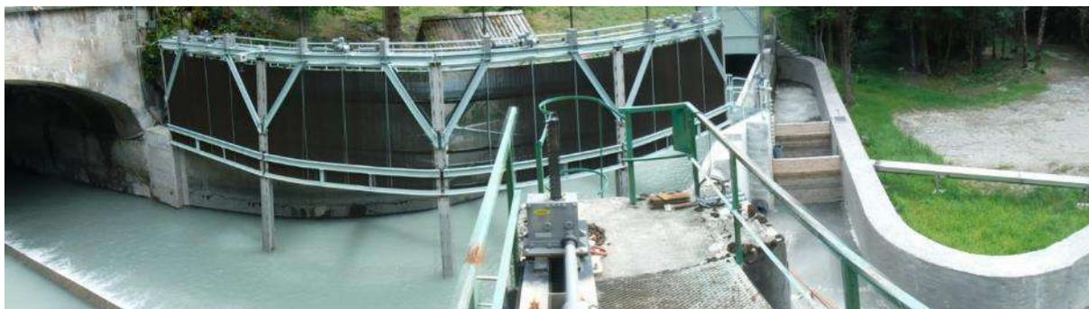
**Figure 105 : Réalisation d'ouvrage de dévalaison sur la Séveraisse (05)**
