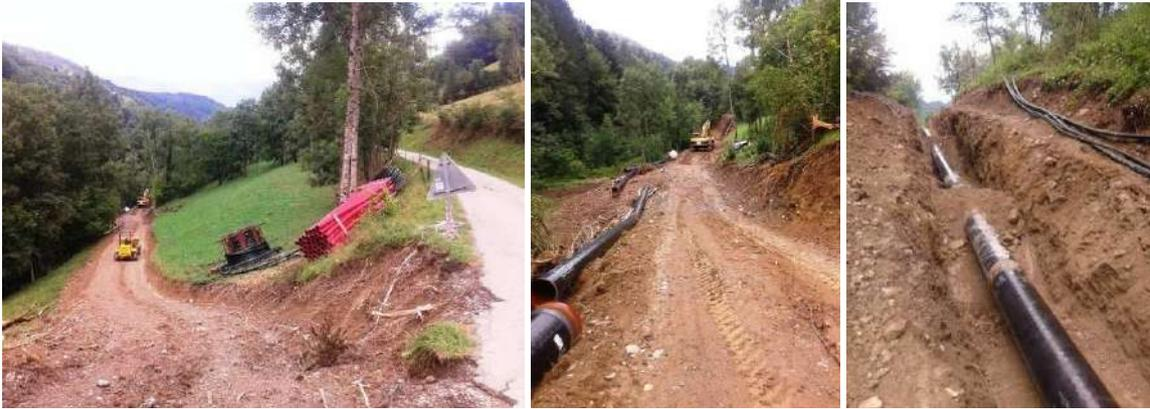
*Piste provisoire pour pose de la conduite sous les terrains naturels*
