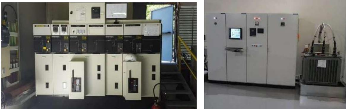
**Figure 39 : Exemple de cellules électriques HTA - Armoires de contrôle commande et transfo auxiliaire**
