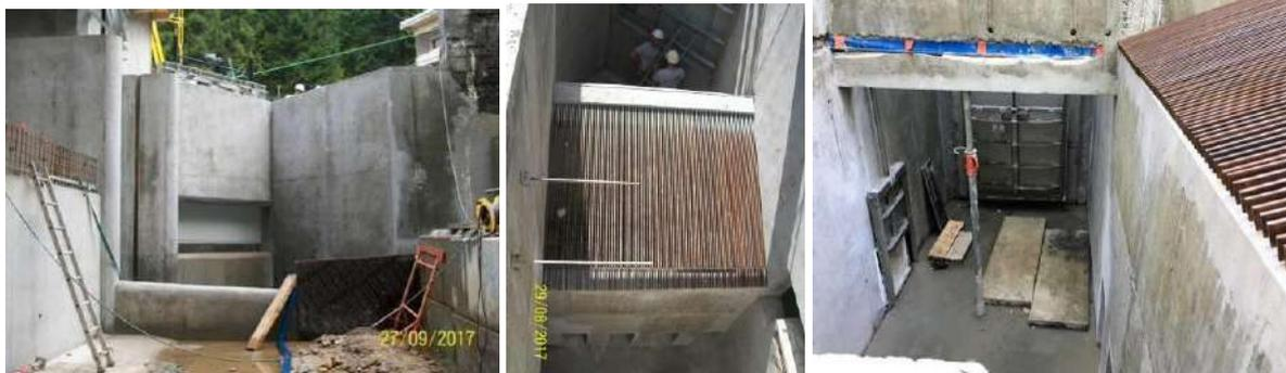
*Pertuis de prise vu depuis l'intérieur de la retenue - Grille inclinée - Chambre de mise en charge, vanne de vidange et vanne de tête CF*
