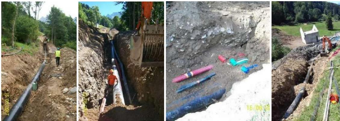
*Pose et remblaiement par criblage sous les terrains naturels*
