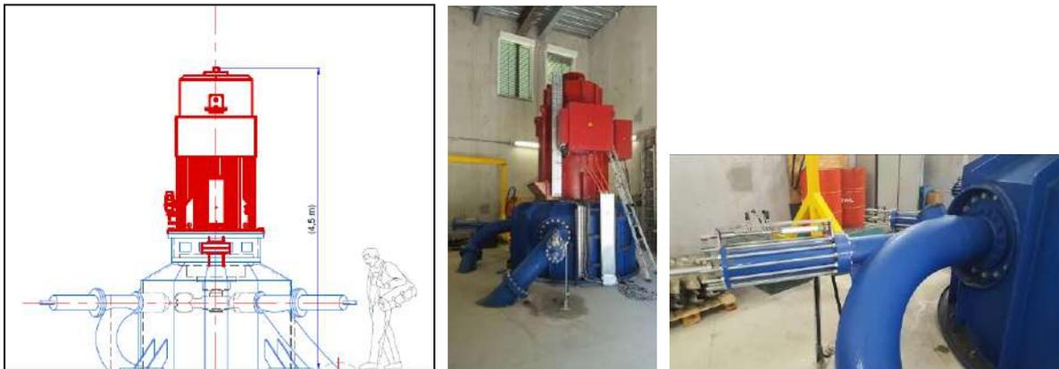
**Figure 38 : Exemple turbine Pelton à axe vertical 3 jets (Glaize)**
