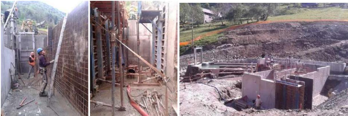
*Réalisation du niveau inférieur, canal de restitution, fosse d'arrivée de la conduite*
