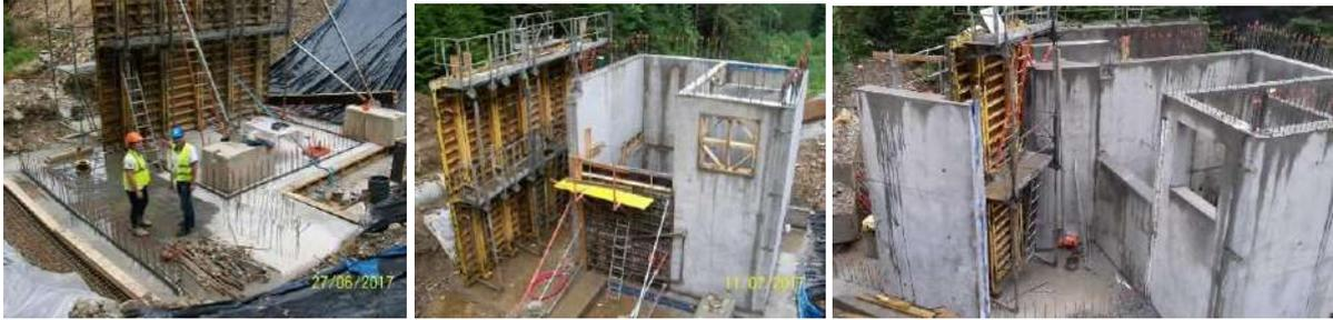
*Exemple de fondations et élévations d'un ouvrage de prise*
